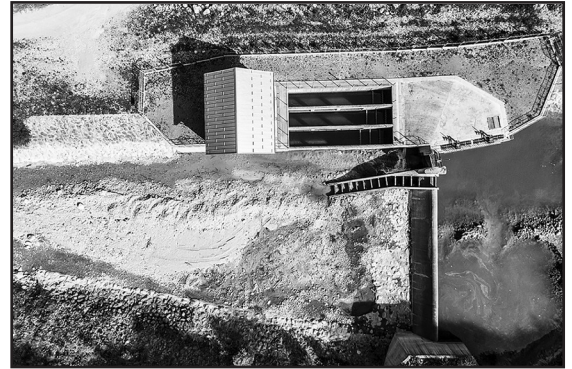
Το νερό εκτρέπεται από τον φυσικό του ρου στην κοίτη του ποταμού και, μέσω σωλήνων, μεταφέρεται εκεί όπου χρειάζεται για να λειτουργήσει, με τους απαραίτητους τεχνικούς όρους, το εργοστάσιο.
