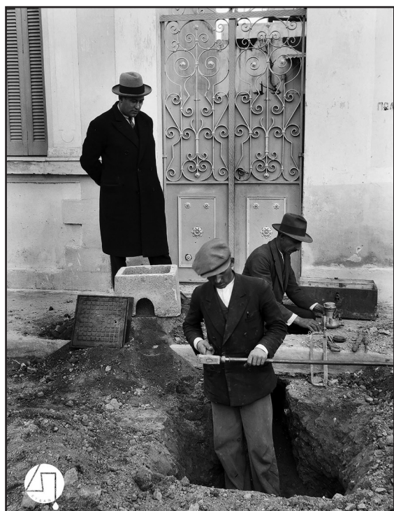
Τοποθέτηση υδρομετρικών στην Αθήνα, το 1927.
